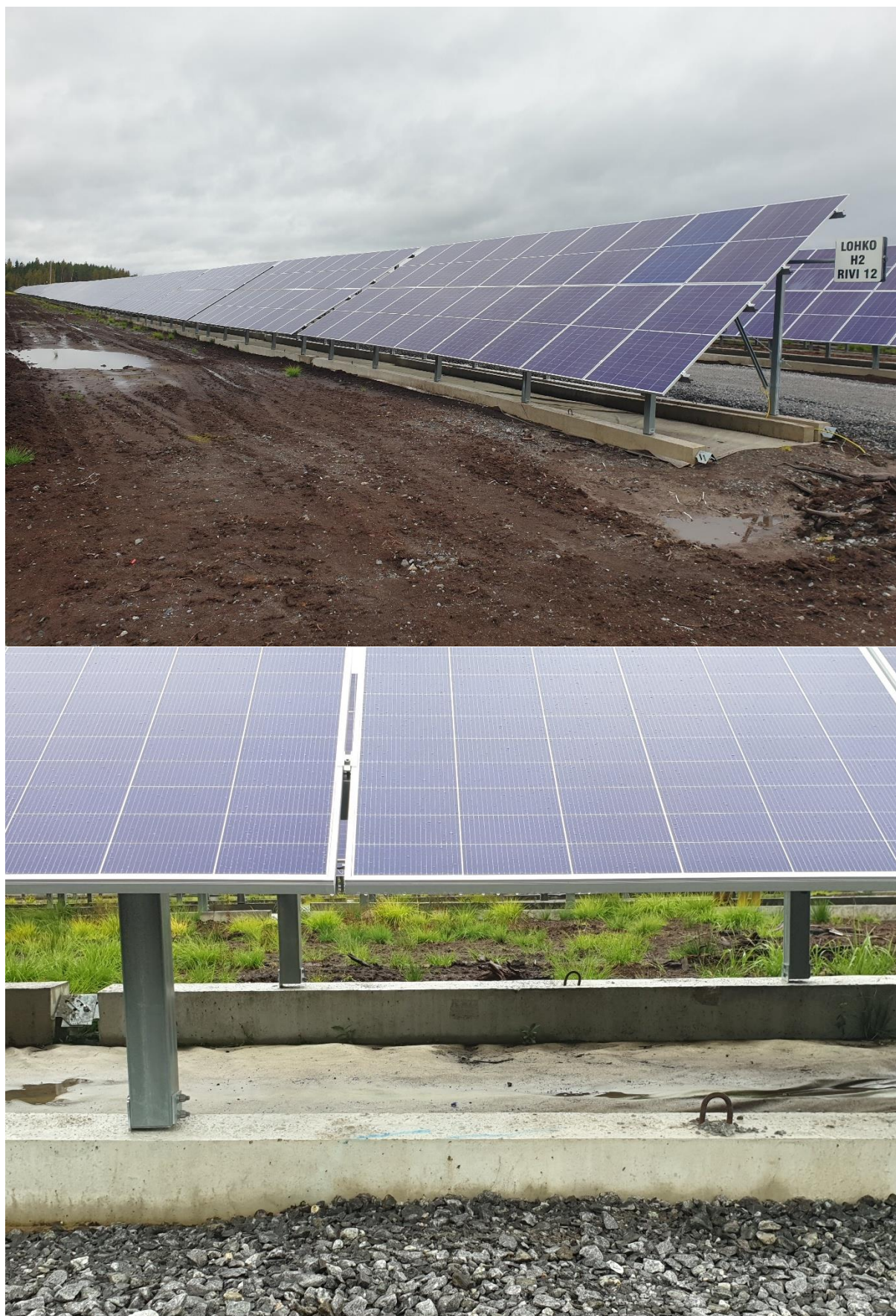
Joonis L2.2. Päisepaneelid ja betoontalad (Alkranel OÜ 15.10.2025).
