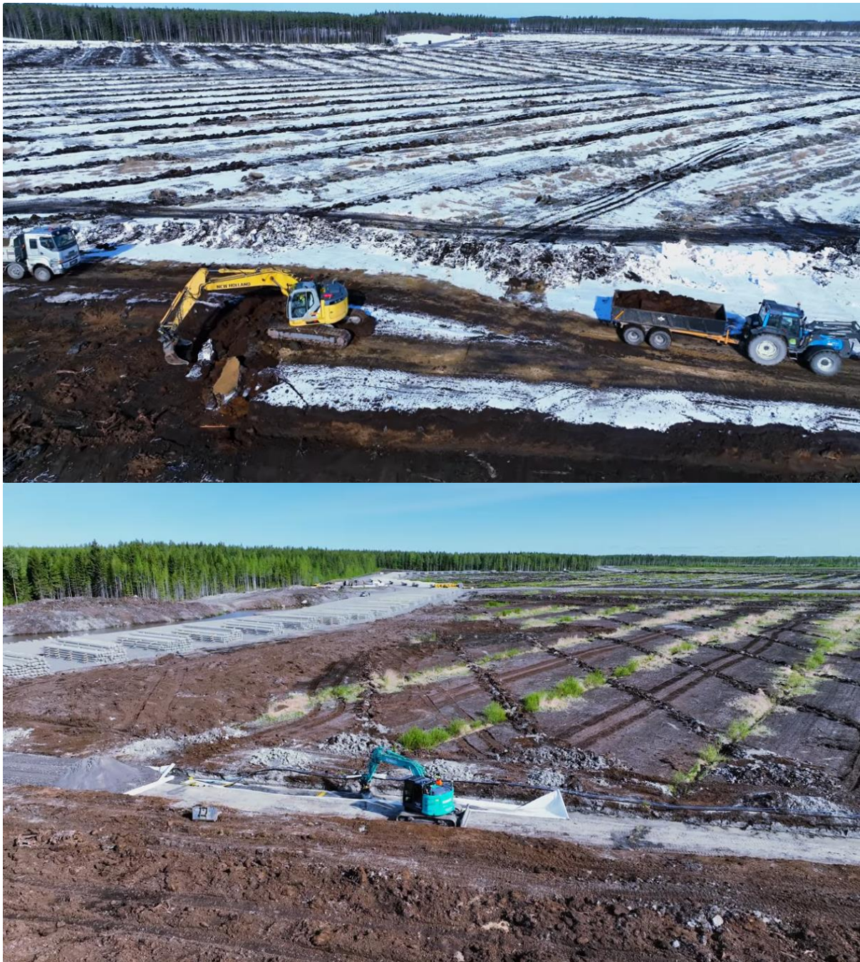
Joonis L2.3. Teede ehitamine päiksepargi alale (EPV Heinineva 2025 Solar power plant, 2025).
